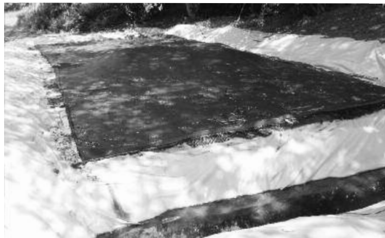
Le Géotube sur la rive du lac Waterloo et un petit bassin de rétention qui se draine dans un lit formé de pierres concassées. — (photo Zoë Ipina, gogoby 2009)
